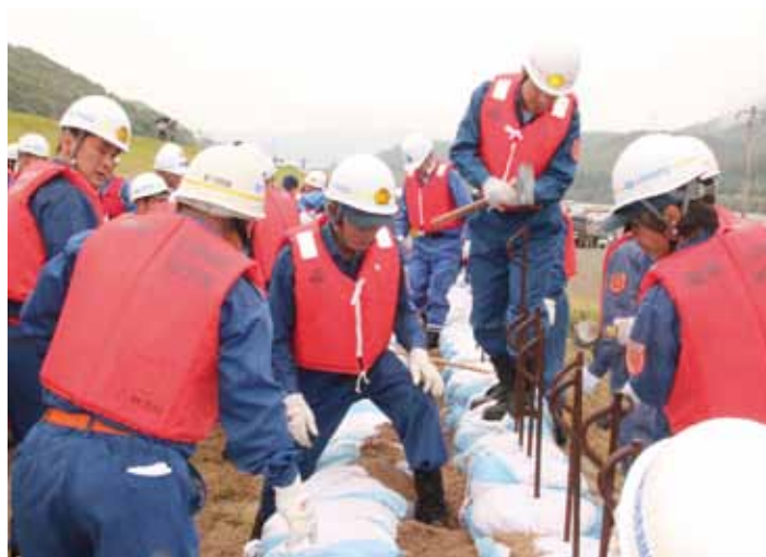
市総合防災訓練（水防工法）
